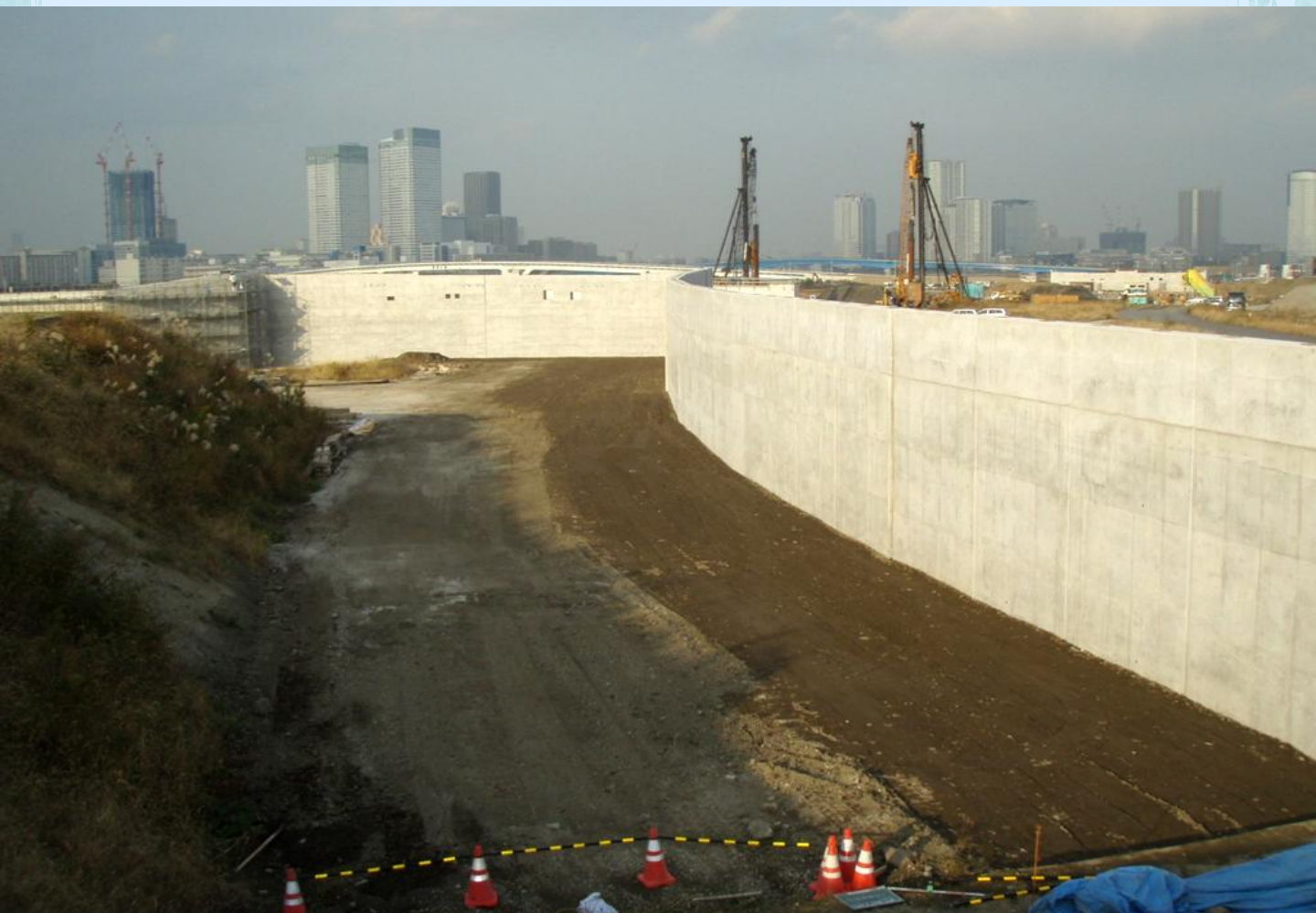
擁壁設置工事及び高架橋下部工事(19豊-11)
