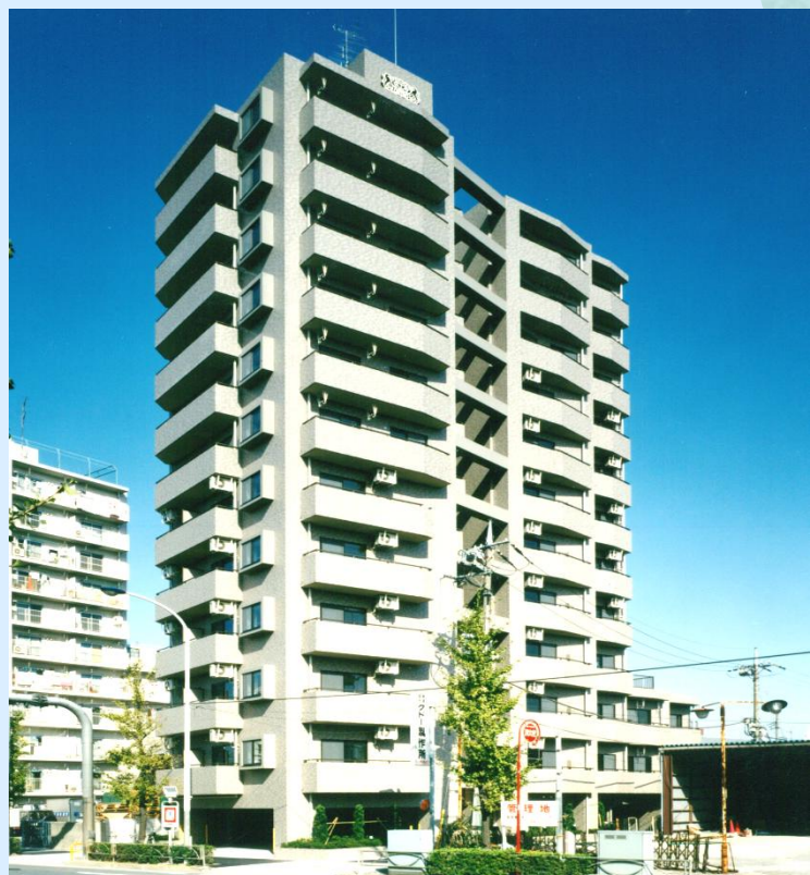
ライオンズマンション足立新築工事
