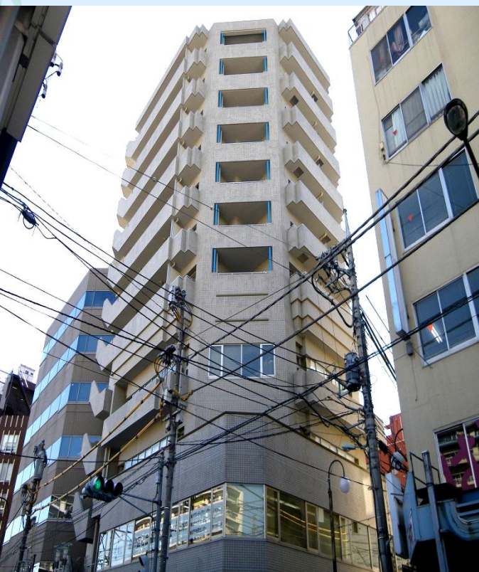
大井一丁目共同ビル外装改修その他工事
