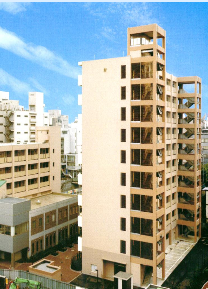
都営住宅西五反田三丁目新築工事
