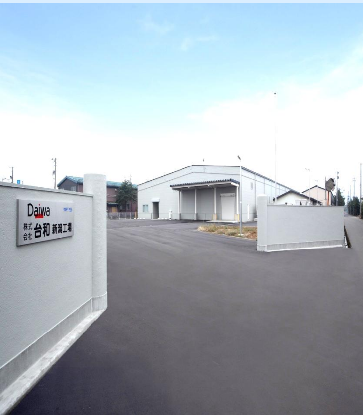
(株)台和新潟工場 増築工事
