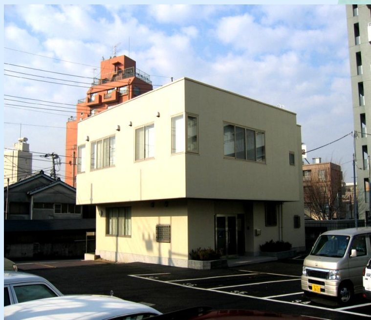
全国瑞穂食料検査協会事務所新築工事
