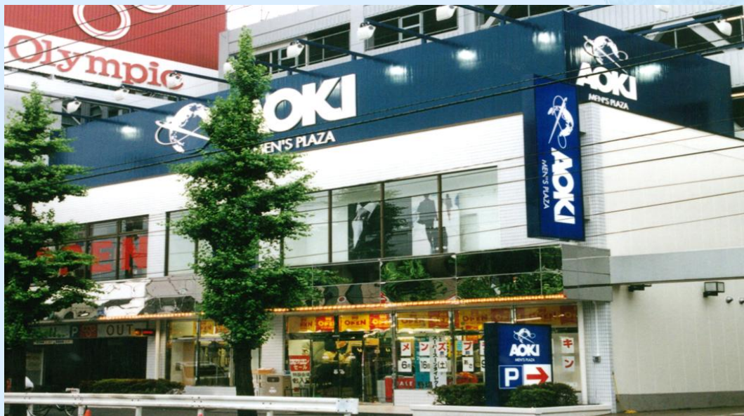
メンズプラザアオキ 鹿島田店改装工事
