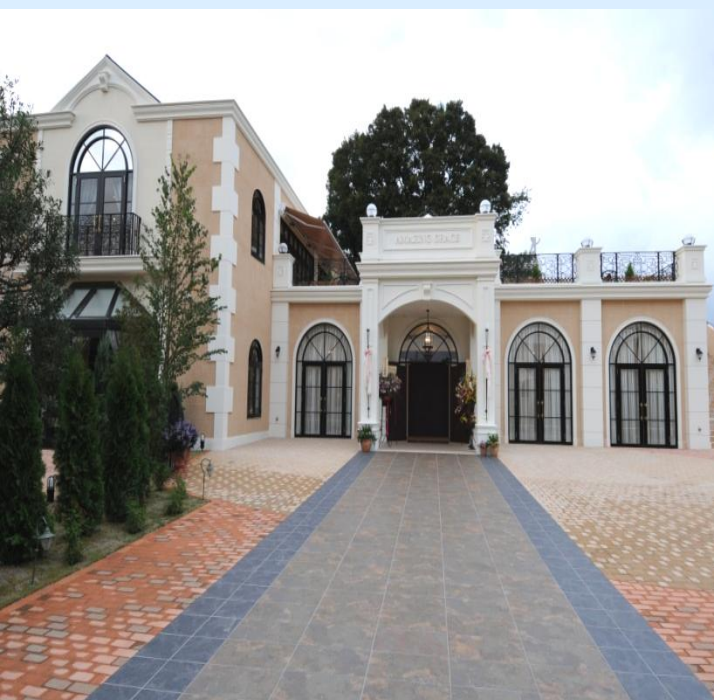
アメイジンググレイス本庄増改築工事
