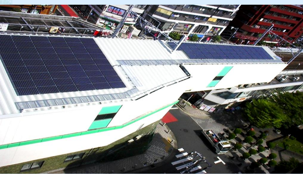
北綾瀬駅乗降場屋根ほか改良建築工事
