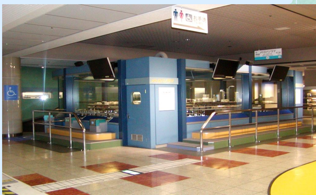
メトロパノラマ見学 コース改修工事
